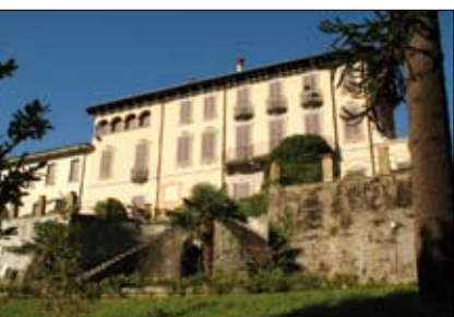
La facciata di Villa Bertarelli
